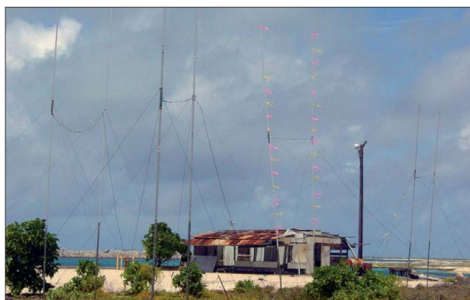
Blick auf einen Teil unserer Antennenfarm; gut sichtbar die umschaltbaren Vertikaldipol-Anordnungen
