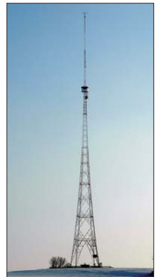
Die 217 m hohe Hauptantenne auf dem Bloenberg (797 m ü. NN) gilt als höchstes Bauwerk der Schweiz. Foto: Rekoki
